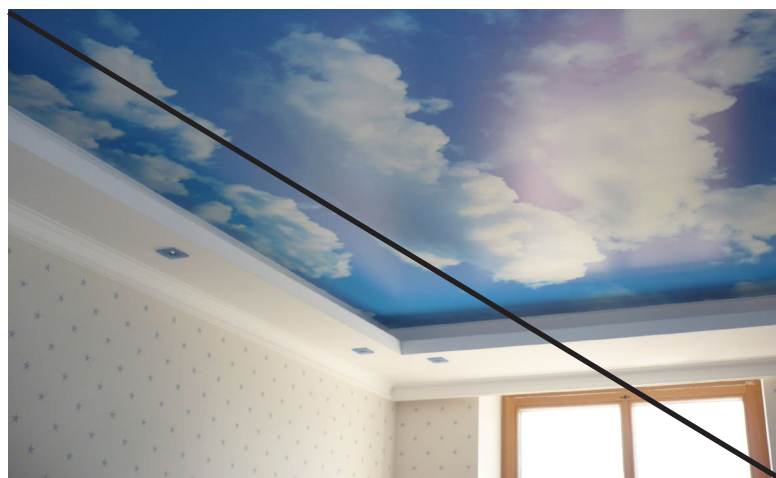
Плохо Натяжные потолки. Потолки с рисунками
